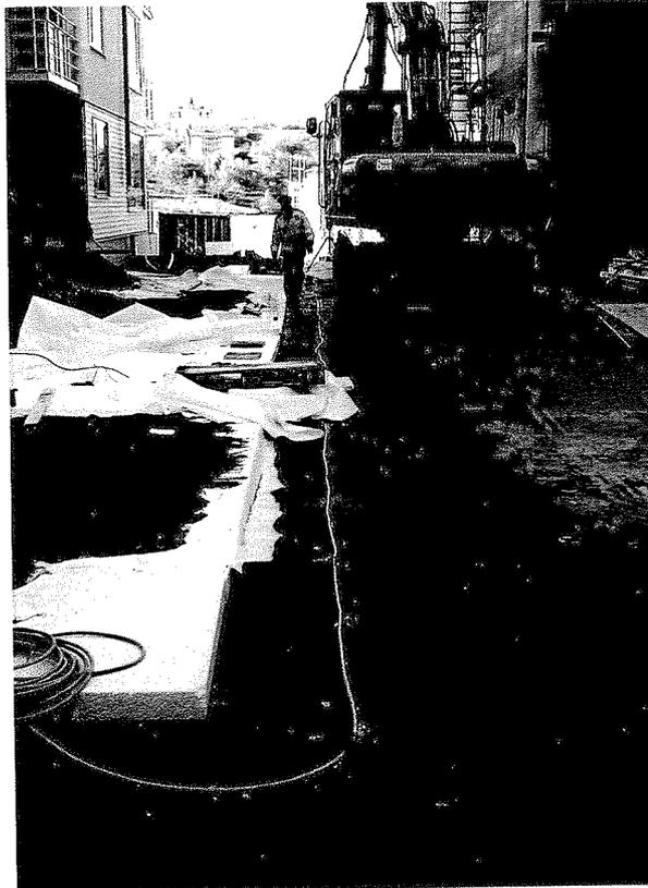
Figur 4: 0-ledningskabel och analyskabel ovanpå tätskiktet.
